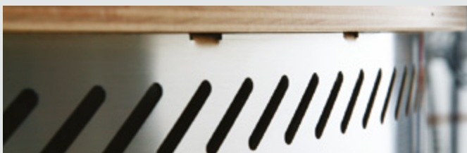
Belüftung des Schrankraums als durchdachtes Designelement
